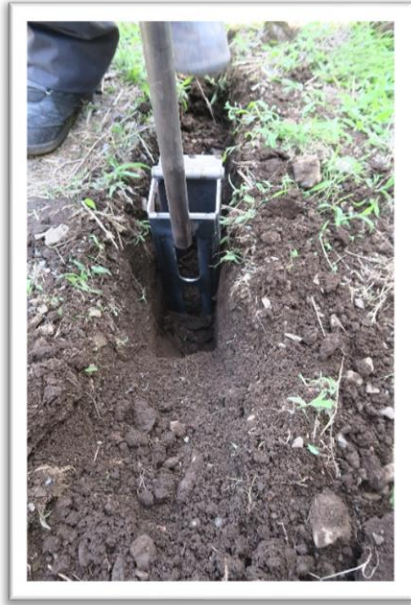
深溝堀作業 深さ40cm
