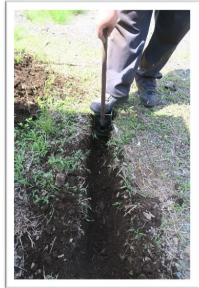
片足溝堀作業 幅10cm
